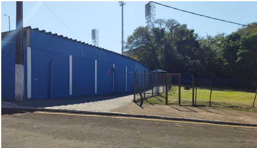
Figura 4 - Portão 3 Arquibancadas Visitante
