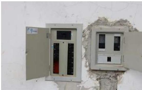
**7.7.2 - Proteção contra sobrecorrente: verificar conformidade entre bitola dos condutores e capacidade de condução de corrente dos equipamentos de proteção.**
