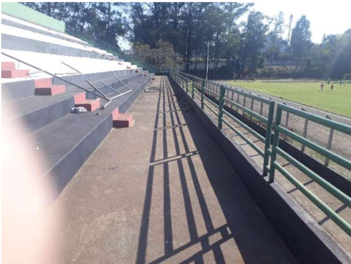
Setor arquibancada principal revestida em concreto desempenado, pintura , muretas e guarda corpos.
