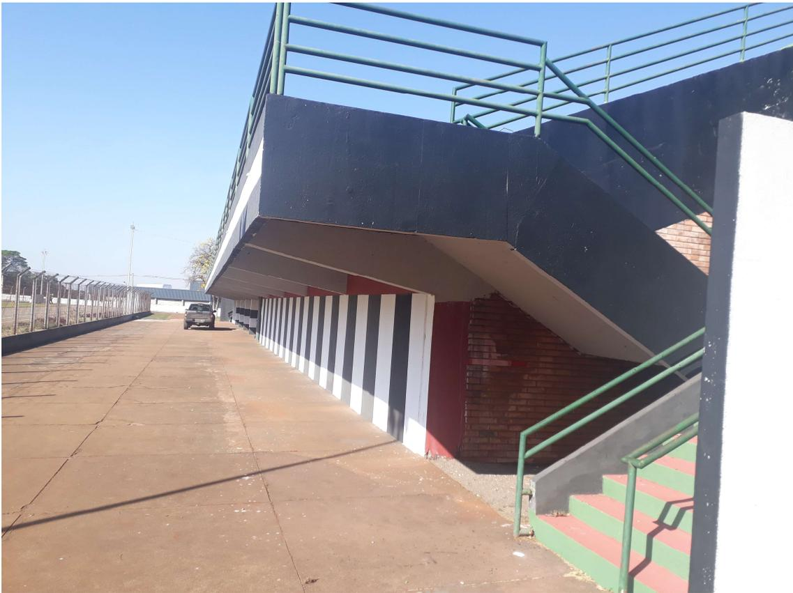
Parte do alambrado cercando o campo, parapeito metálico de acordo com Normas na arquibancada e escadaria de acesso para arquibancada.
