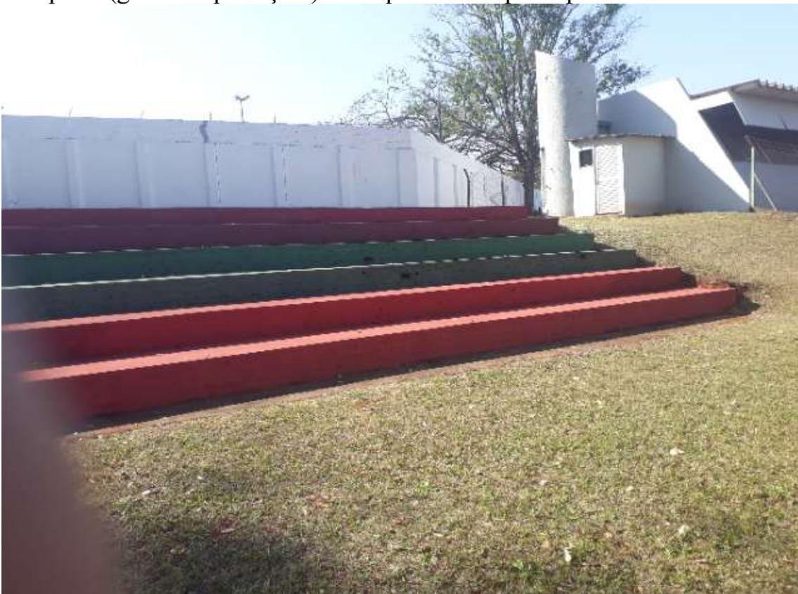
Muro do fundo em alvenaria e pintura latexpva e arquibancada visitantes em alvenaria e pintura latexpva.
