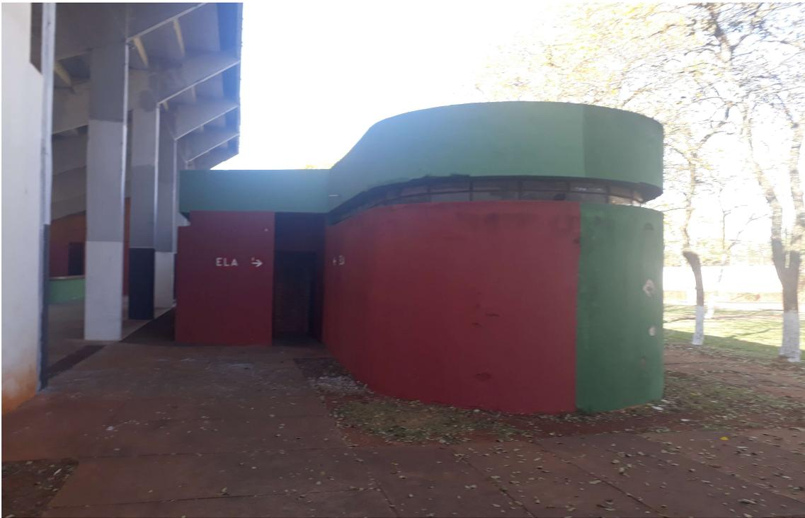
Cobertura dos banheiros em laje pre-fabricada e cobertura embutida com estrutura de madeira e telhas fibroamianto.
