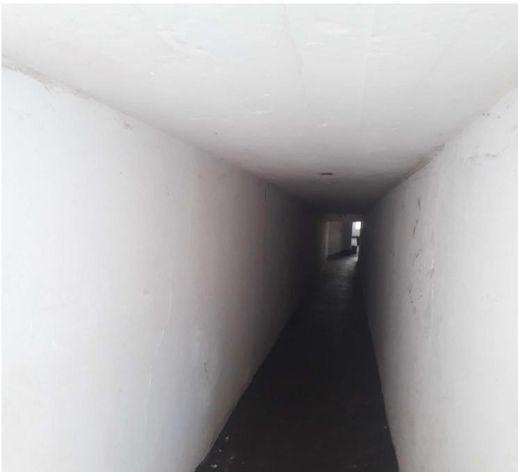
Corredor dos vestiários com laje impermeabilizada e sem problemas de umidade.
