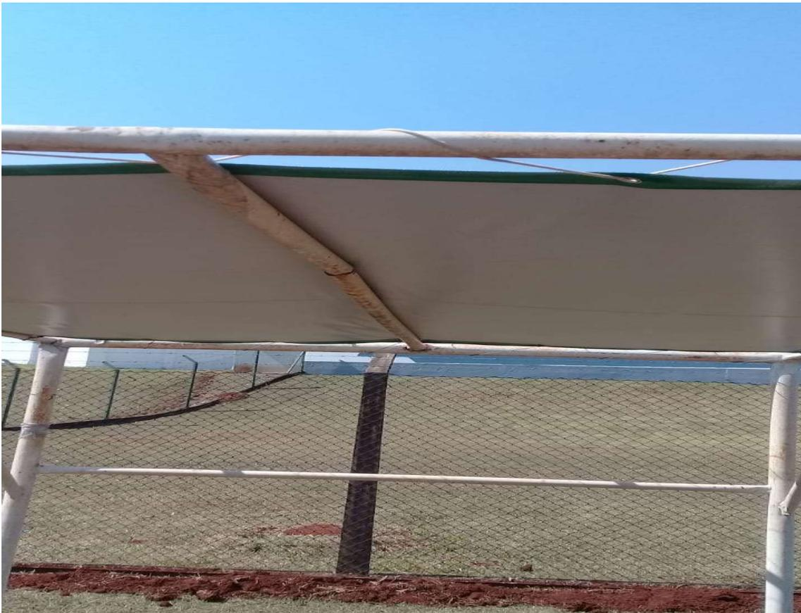
Cobertura para o sistema de policiamento, em estrutura metálica e telhas em aço inox
