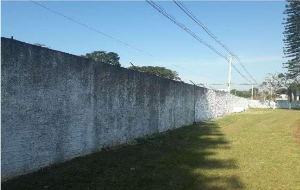
Todo estádio é cercado por muro de alvenaria com pintura em latex.
