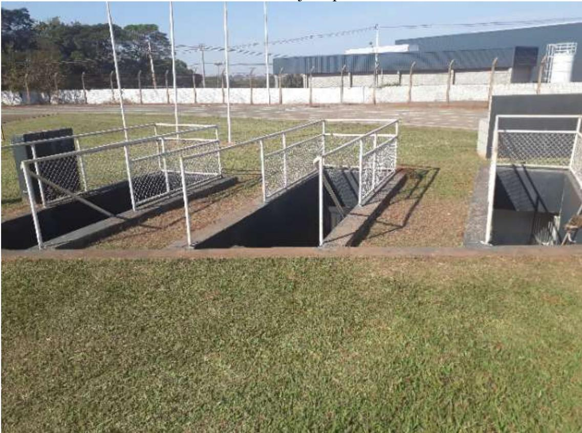
Cobertura vestiários subterrâneos com laje em concreto armado impermeabilizado
