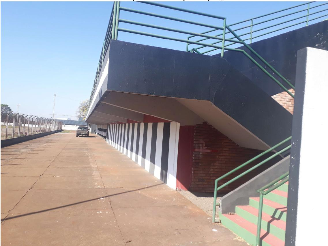
Arquibancada principal em concreto armado e alvenaria com pintura em tinta latex pva
