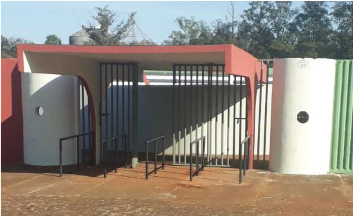
Cobertura bilheteria em concreto armado e laje impermeabilizada
