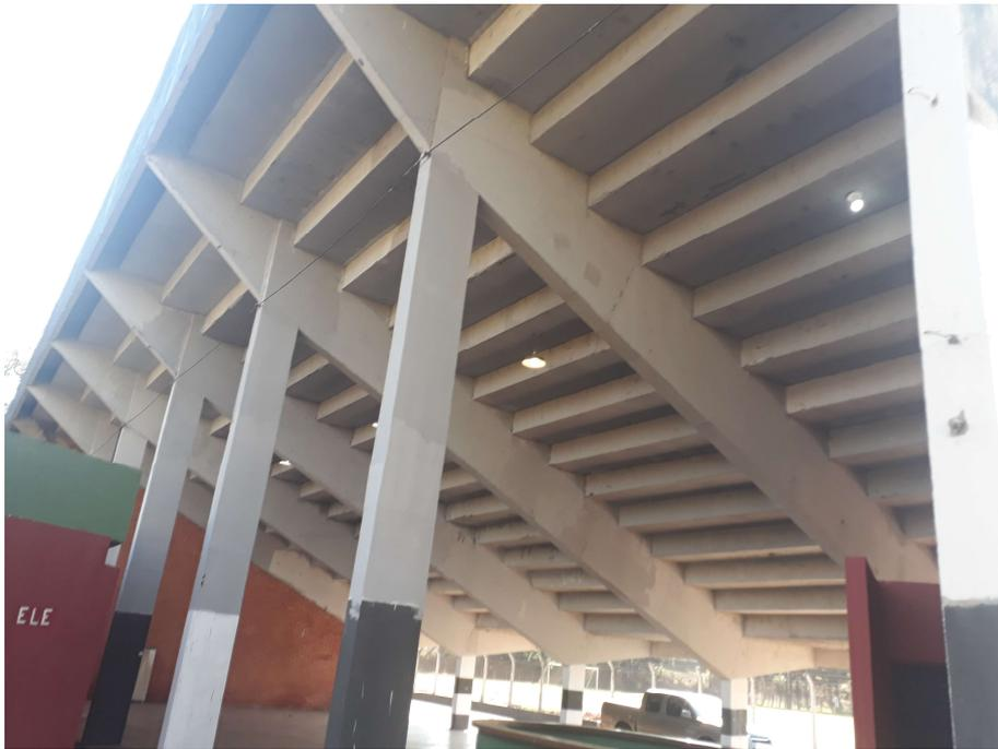
Fotografia mostrando a arquibancada principal do lado externo e na parte de baixo desta. Podemos notar que não possui nenhuma deformidade, nenhuma trinca ou fissuras.
