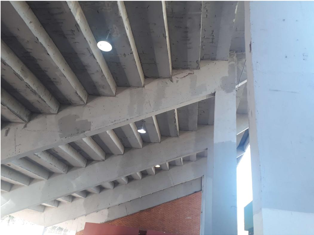
PODEMOS OBSERVAR QUE A PARTE INFERIOR DA ARQUIBANCADA NÃO POSSUI QUALQUER TIPO DE INFILTRAÇÃO, PODENDO ASSIM AFIRMAR QUE O SISTEMA DE IMPERMEABILIZAÇÃO DA ARQUIBANCADA ESTA EM PERFEITO ESTADO, ALÉM DE SER COBERTO
