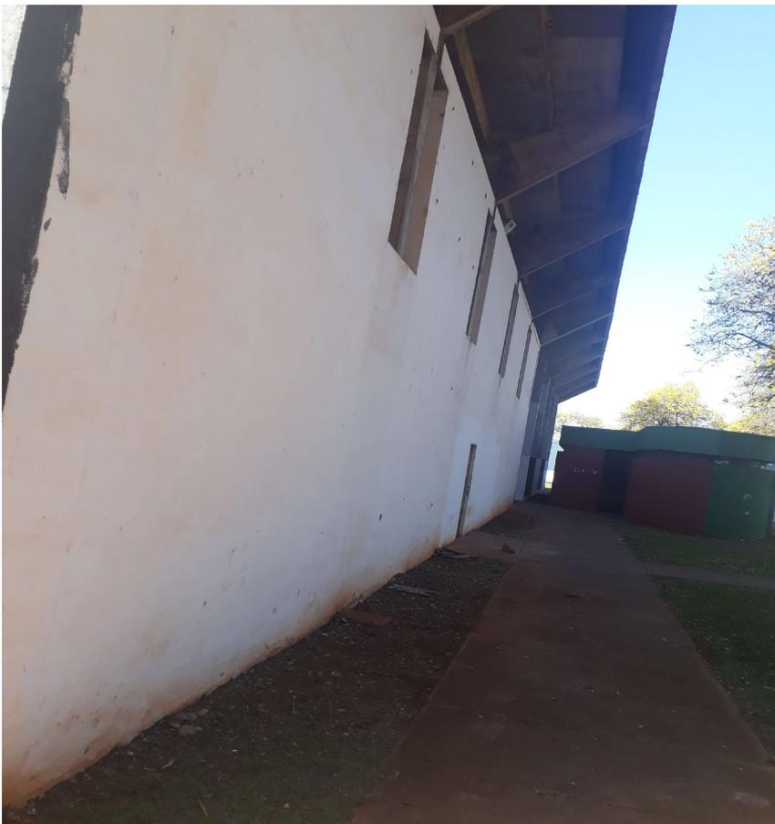
Mostra do revestimento dos banheiros local aos fundos e parede abaixo arquibancadas em alvenaria rebocadas e pintadas em latexpva.
