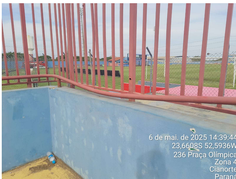
Foto 36– Guarda-corpo / corrimão em mal estado de conservação
