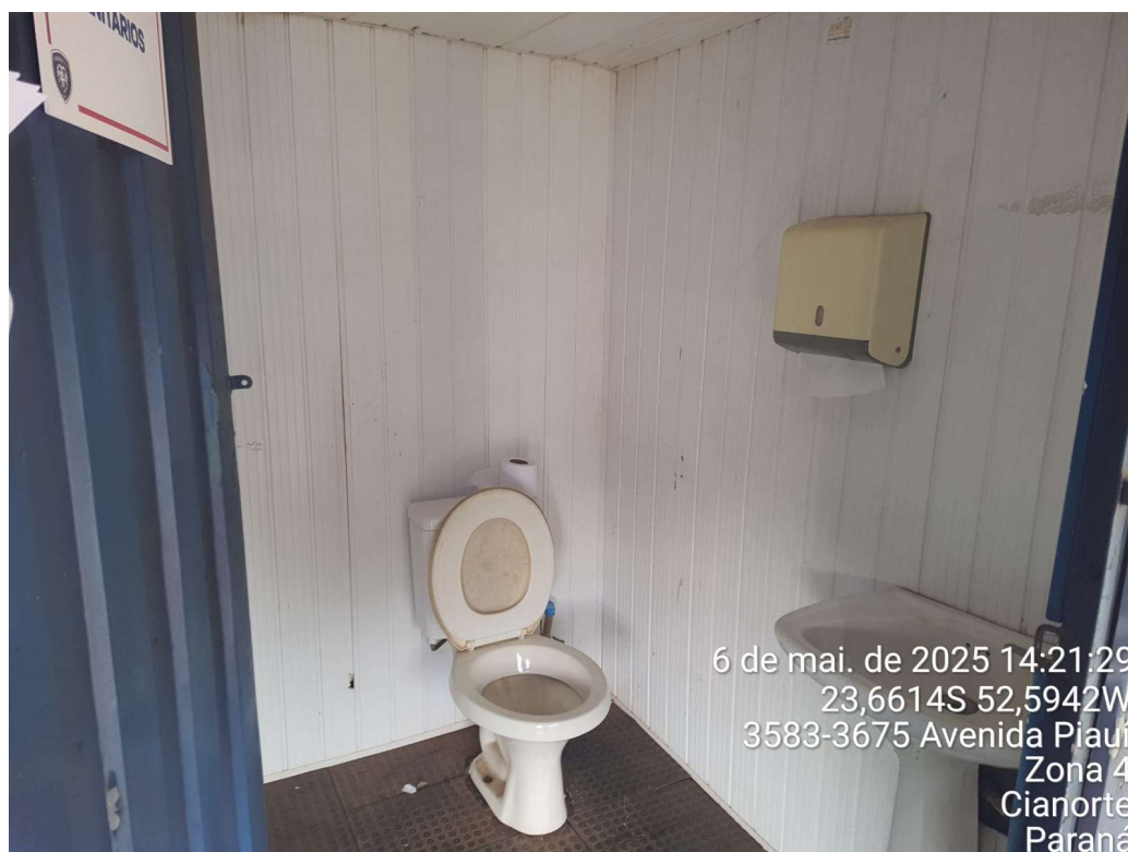
Foto 49 – Sanitário destinado às cabines de imprensa não adaptado conforme dispõe a Norma Brasileira de Acessibilidade
