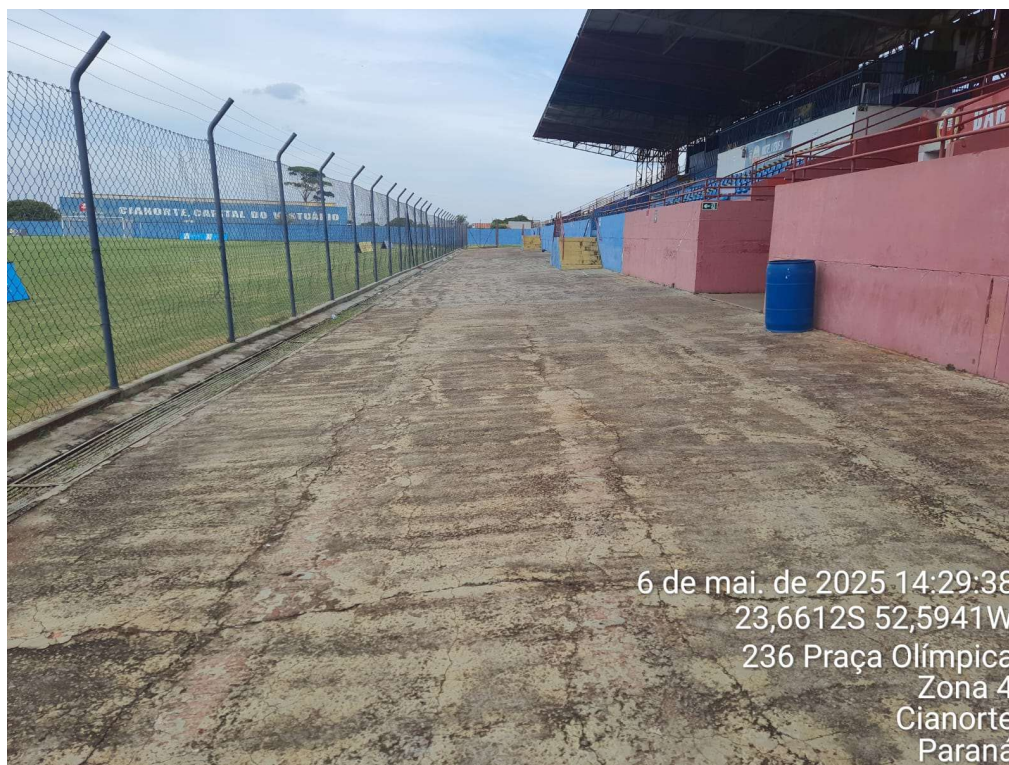
Foto 50 – Ausência de sinalização tátil e demais elementos normatizados em todos os setores do estádio
