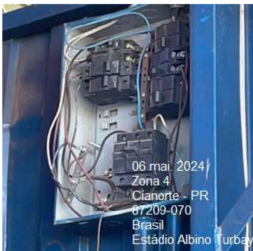
Fotos 41 e 42 – Caixas elétricas de tomadas sem placa de fechamento e disjuntores e caixas expostas ao contato das pessoas
