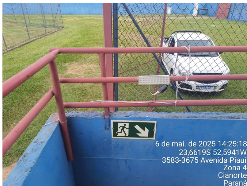
Foto 44 – Luminárias de emergência necessitam de manutenção
