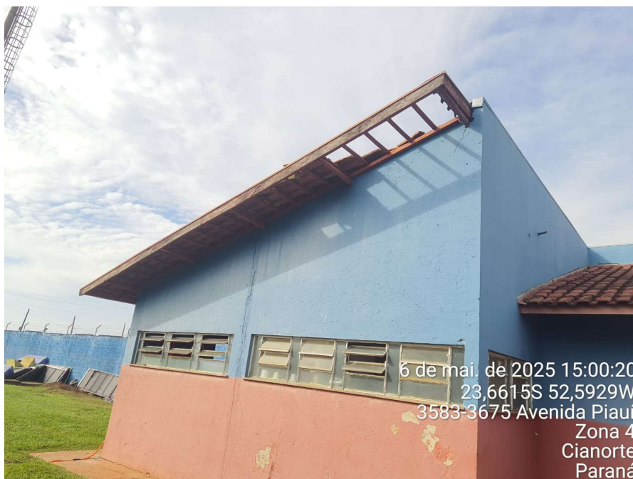
Foto 38 – Más condições do sistema de cobertura dos vestiários de arbitragem
