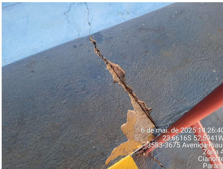
Foto 30 – Juntas de dilatação na arquibancada principal que necessitam de recuperação
