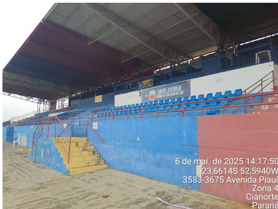
Foto 27 – Arribancada principal com pintura em mal estado de conservação
