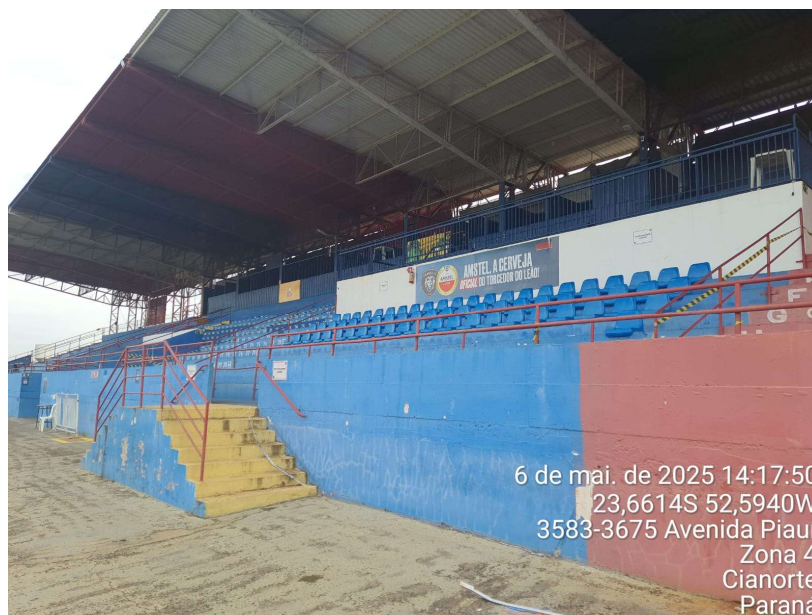
Foto 34 – Pintura das arquibancadas em mal estado de conservação e com sinais de umidade
