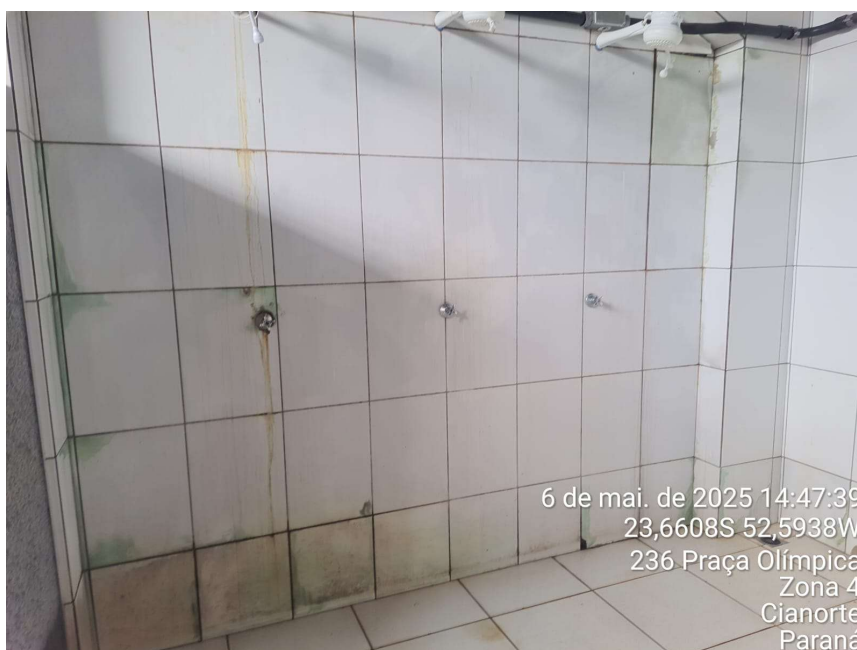
Foto 33 – Revestimento cerâmico dos vestiários em más condições
