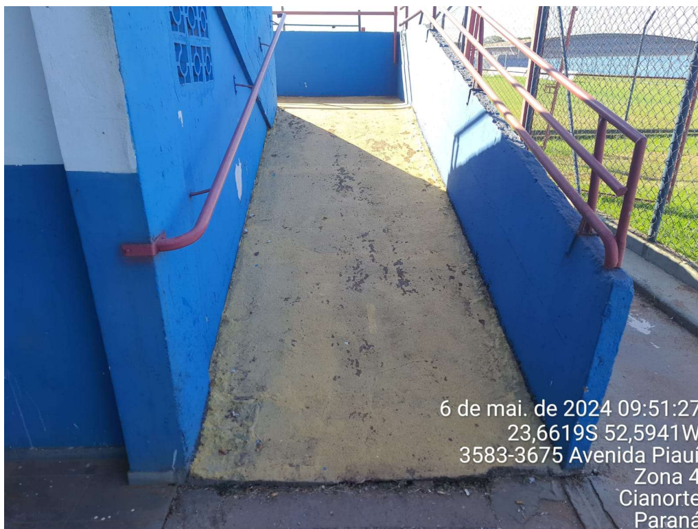
Foto 48 – Rampas de acesso das arquibancadas cobertas com inclinação superior à exigida pela Norma Brasileira de Acessibilidade
