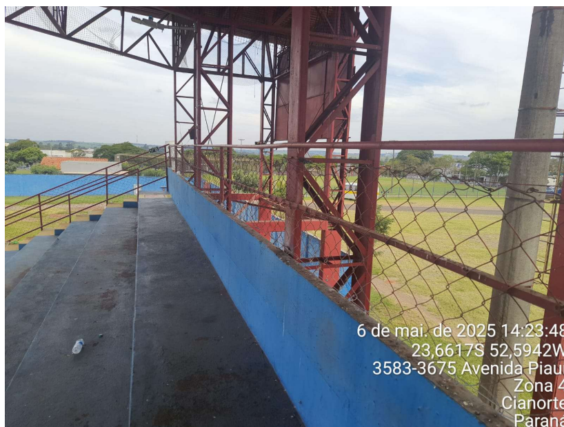
Foto 37– Guarda-corpo / corrimão em mal estado de conservação
