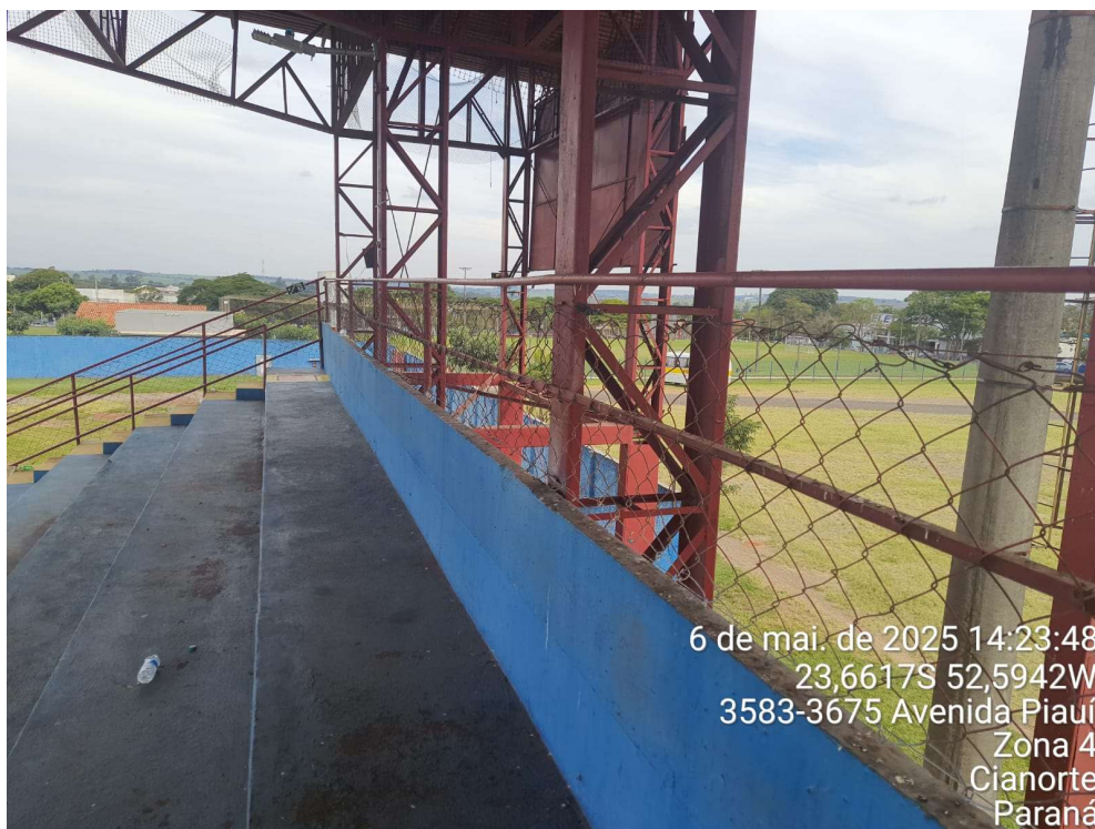
Foto 28 – Gradil de proteção nas arquibancadas cobertas com modelo e dimensões incompatíveis
