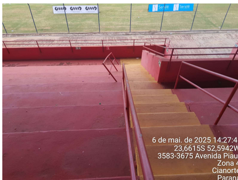
Foto 35– Guarda-corpos mal fixados no piso de concreto
