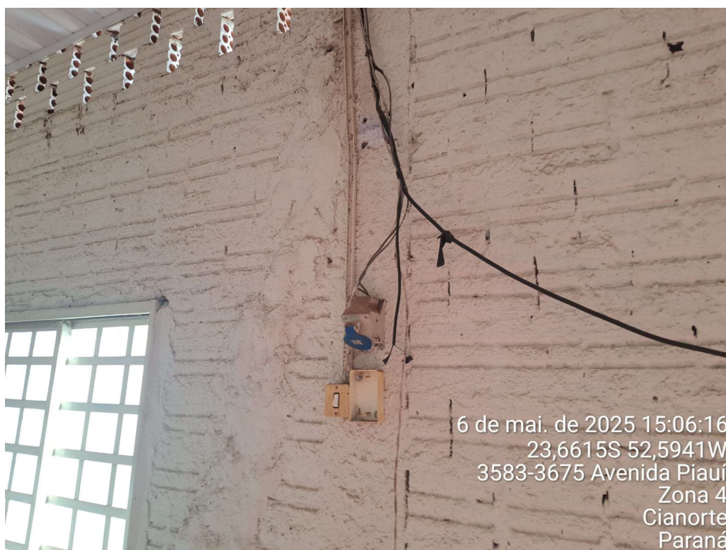
Fotos 39 e 40 – Fiação exposta e em contato direto com o público da arquibancada e funcionários
