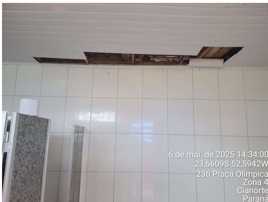
Foto 32 – Cobertura e forro dos sanitários da arquibancada descoberta em más condições
