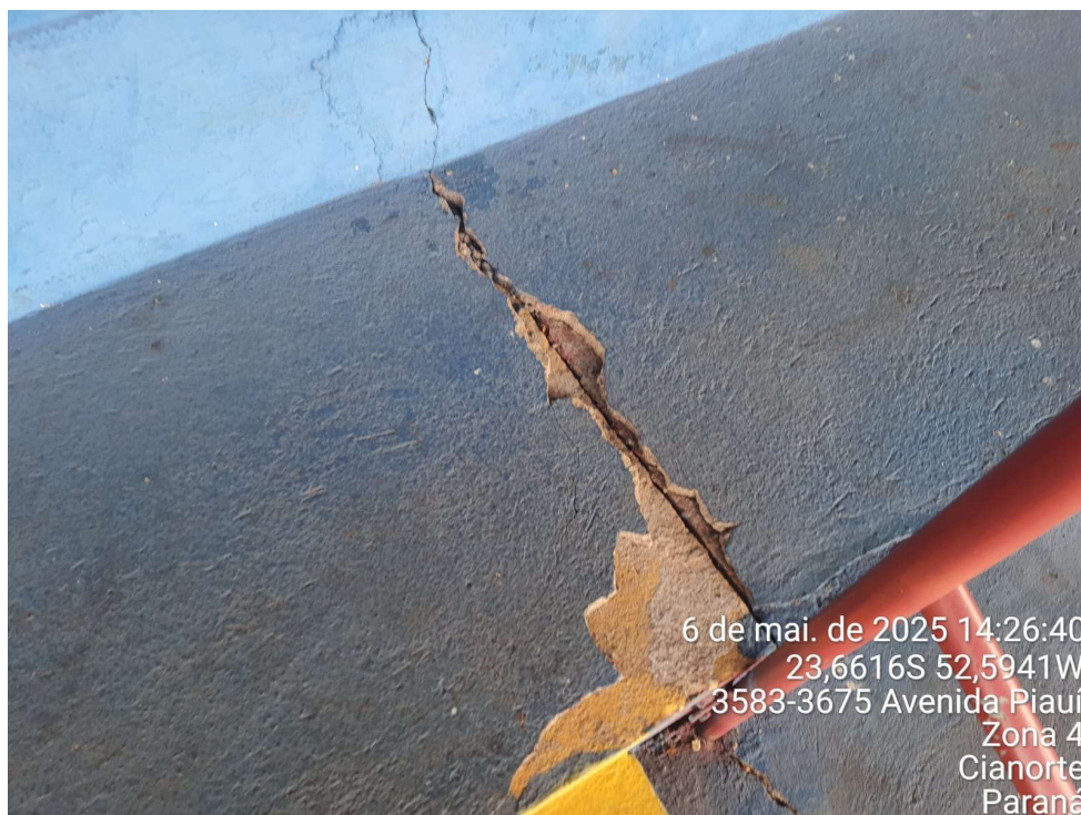
Foto 25 – Junta de dilatação das arquibancadas cobertas
