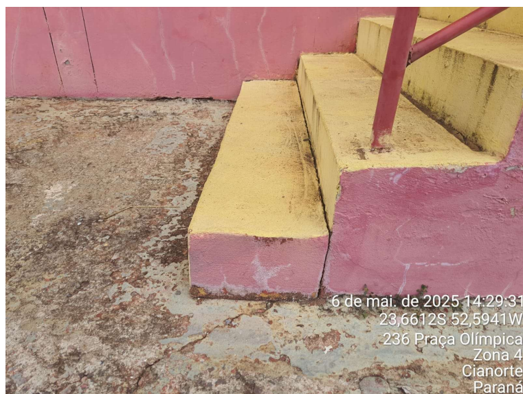
Foto 45 – Primeiro degrau de uma das escadas encontra-se “solto” do restante da estrutura
