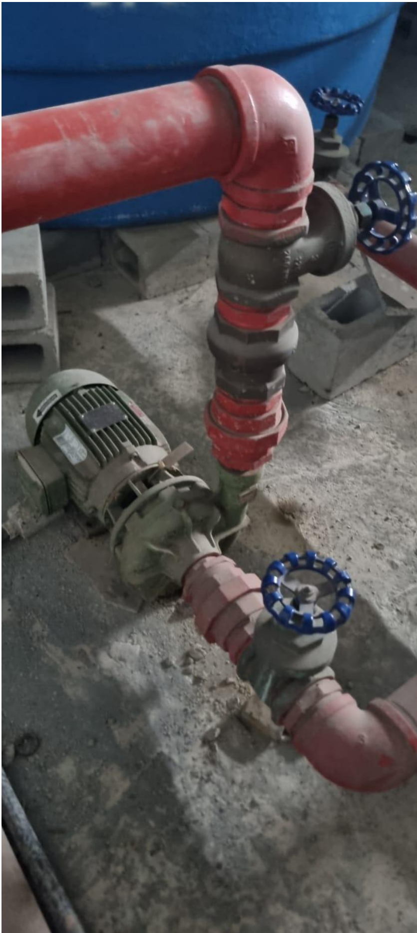
Figura 16 C:\Users\Parana Clube\Downloads\BOMBA SISTEMA HIDRANTE.jpeg
