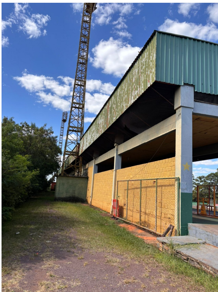
Acesso à Torre de Iluminação
