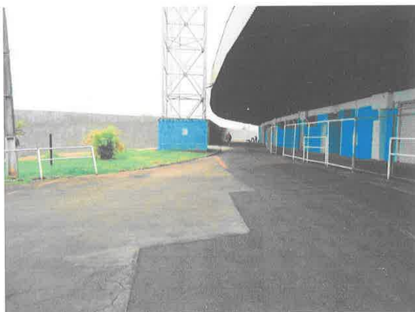
Vista do recape no asfalto
