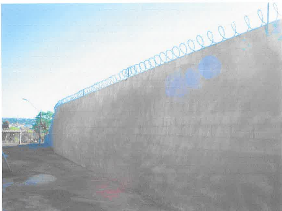
Vista do muro de divisa do Autódromo
