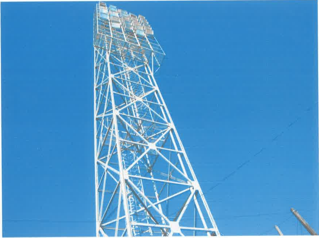
Torre de iluminação
