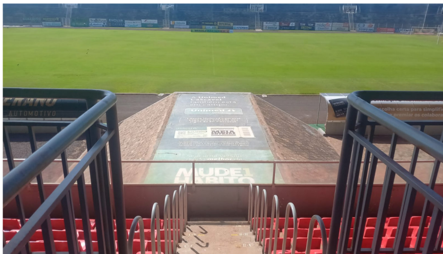
Figura 03 – Proteção superior do túnel.
