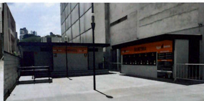
Estrutura de banheiros e guarda volumes
