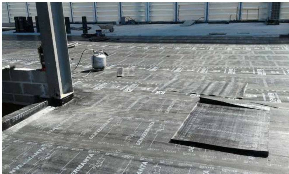
FOTO: Manta asfáltica sobre laje exposta
