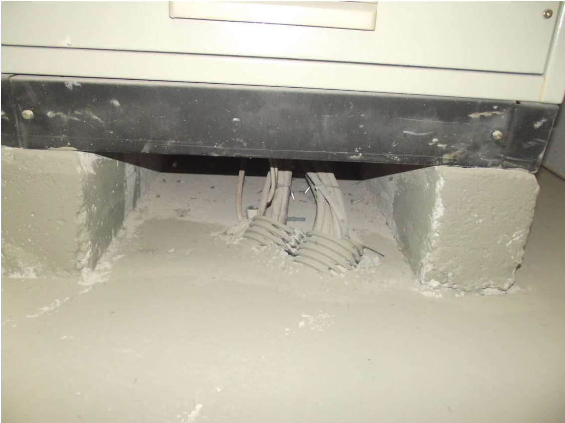
FOTO: Bacos de eletrodutos subterrâneos
