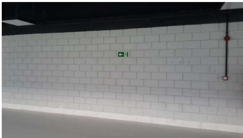
FOTO: Alvenaria Estrutural Corredor Setor 2
