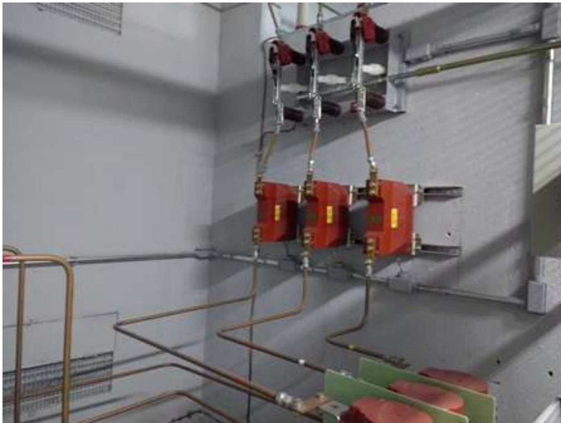
FOTO: Chaves seccionadoras
