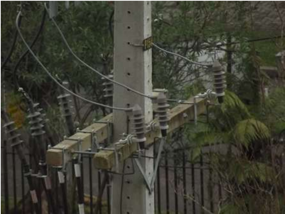
FOTO: Para raio de distribuição
