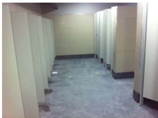
FOTO: Divisórias nos banheiros
