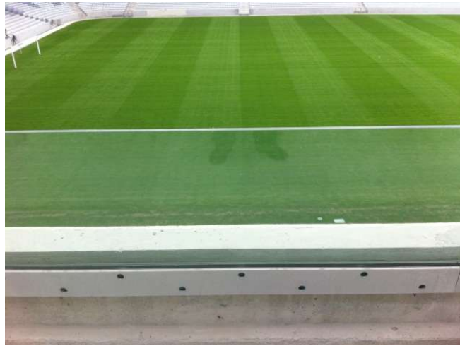
FOTO: Guarda corpo de vidro inferior.
