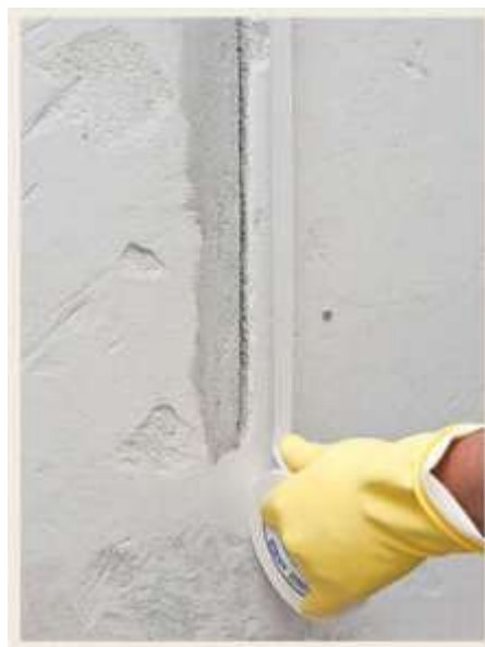
Aplicar fita adesiva nas laterais para evitar que restos de selantes sujem a superfície
