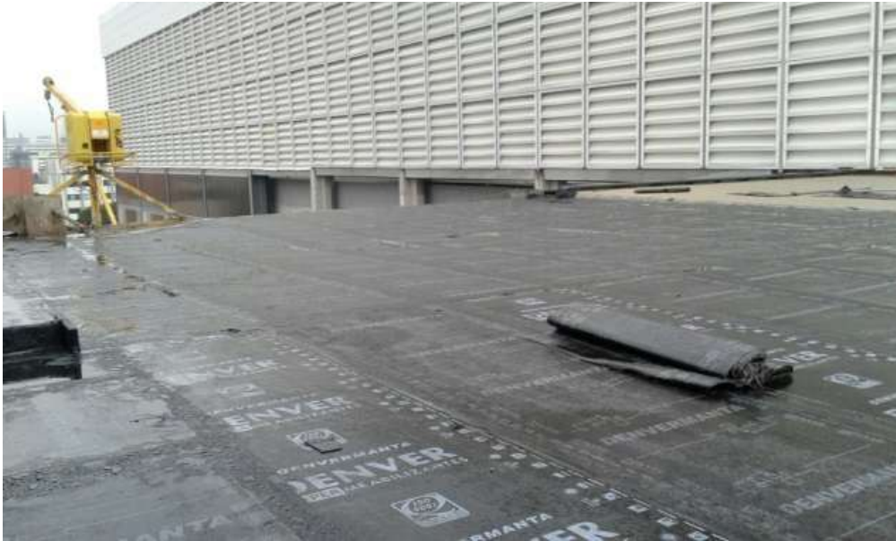
FOTO: Sistema de impermeabilização
