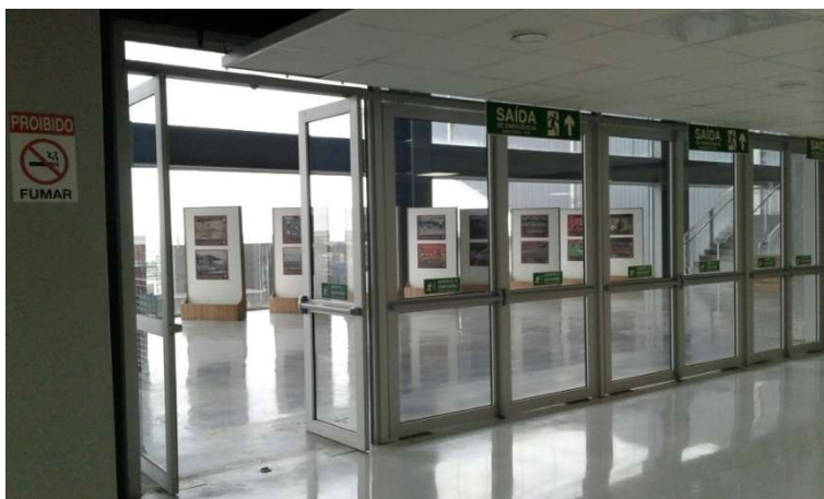
FOTO: Saídas de emergência
