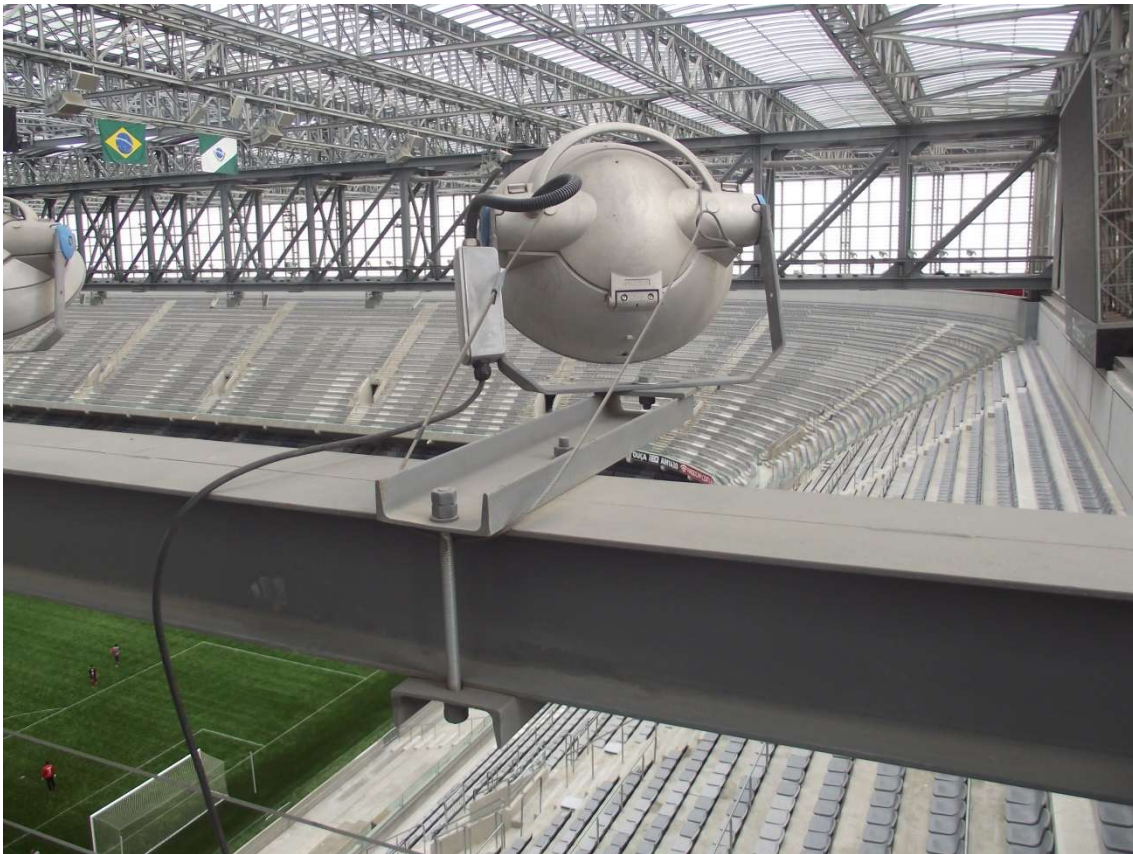
FOTO: Fixação luminária campo
