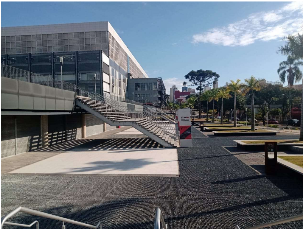
FOTO: Calçada em frente ao Estádio
