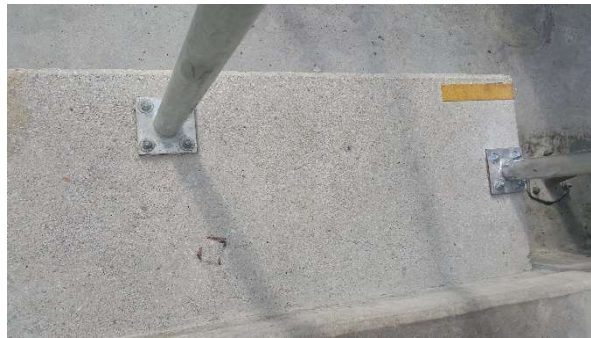
FOTO: Detalhe da fixação do corrimão
