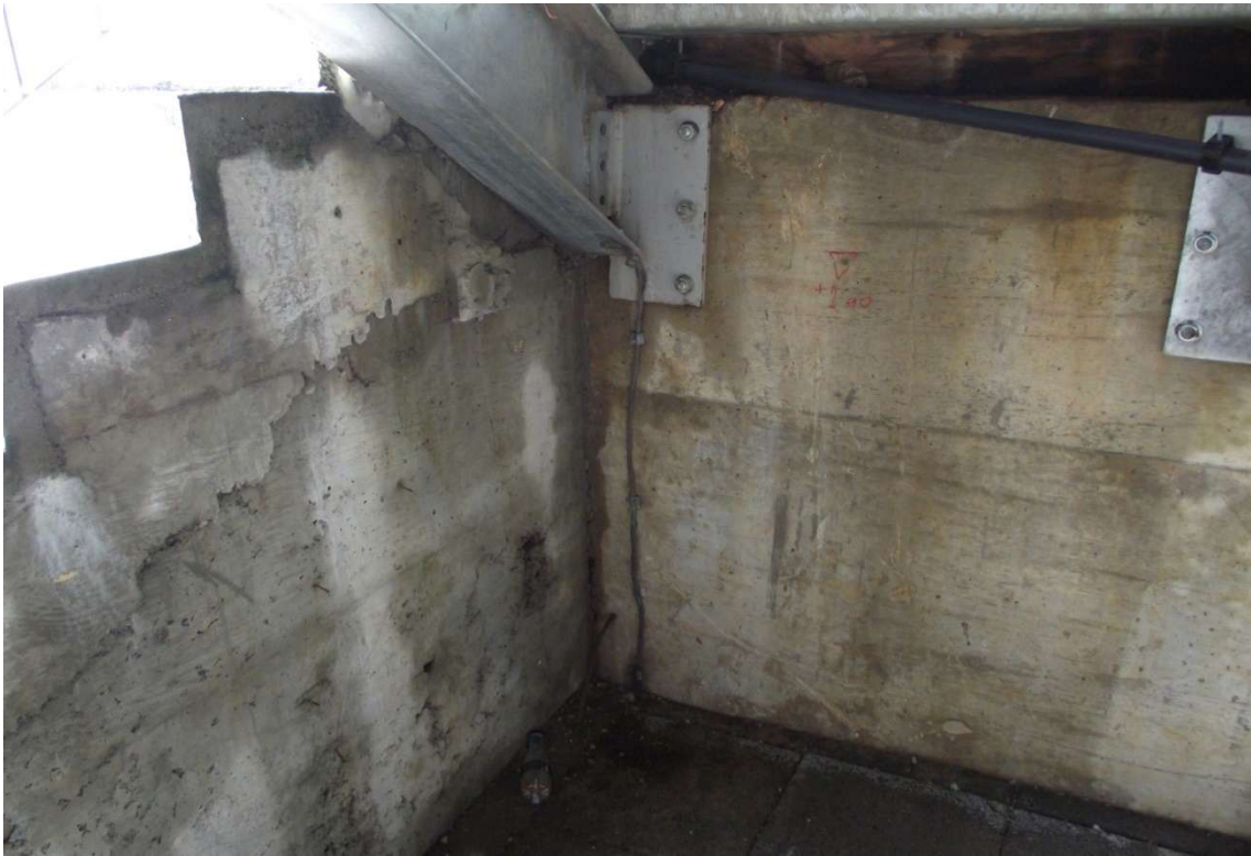
FOTO: Aterramento sistema de equipotencialização principal
