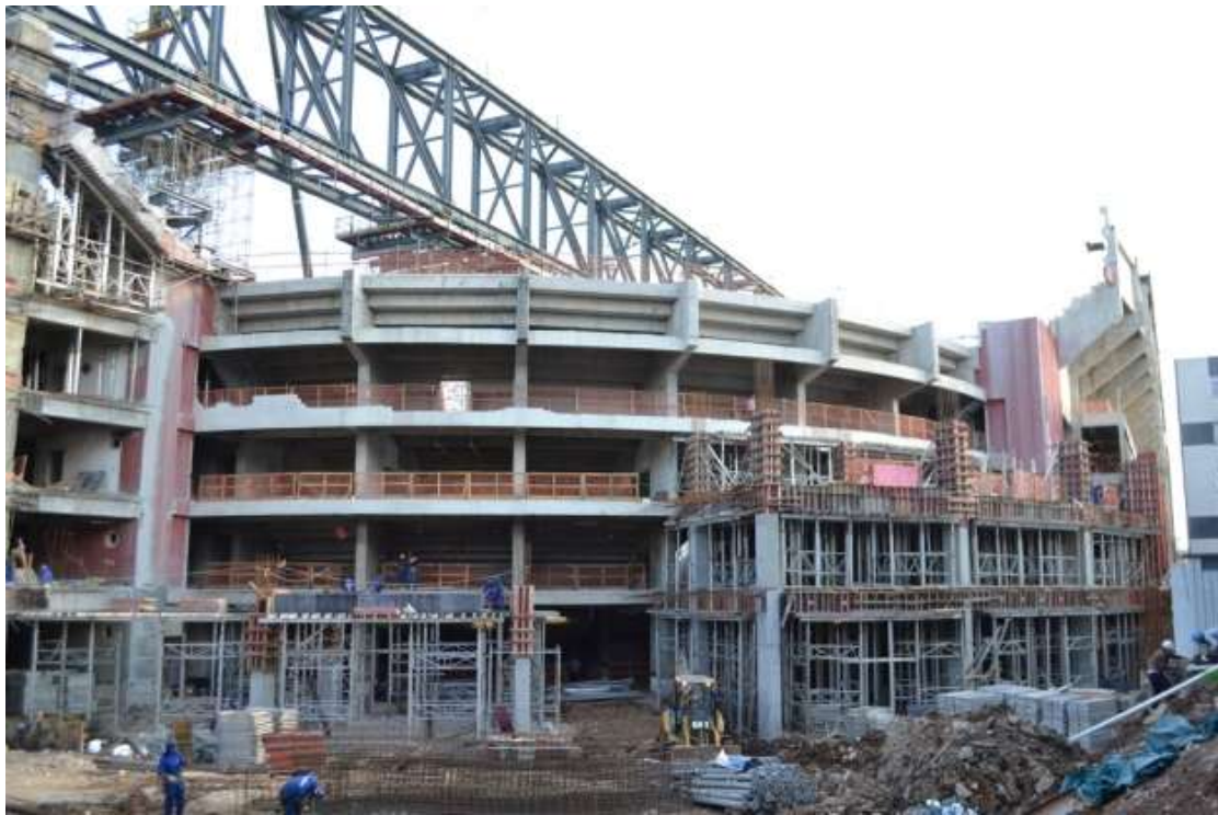
Foto: Detalhe da execução das estruturas moldadas in loco (06/2013)
