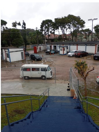
Figura 10 – Acesso ao estacionamento das viaturas policiais.
