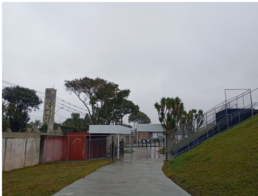
Figura 10 – Reformas realizadas nos portões de acesso.
