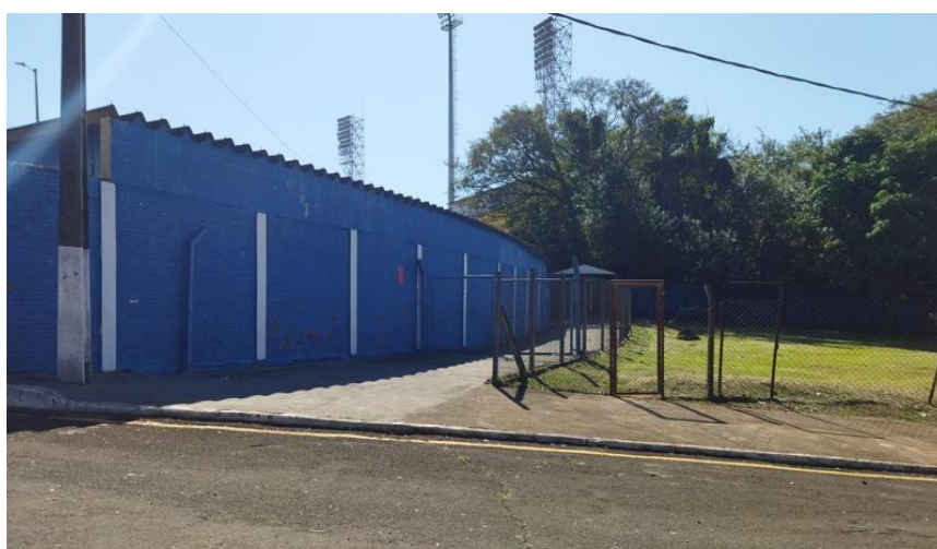
Figura 4 - Portão 3 Arquibancadas Visitante
