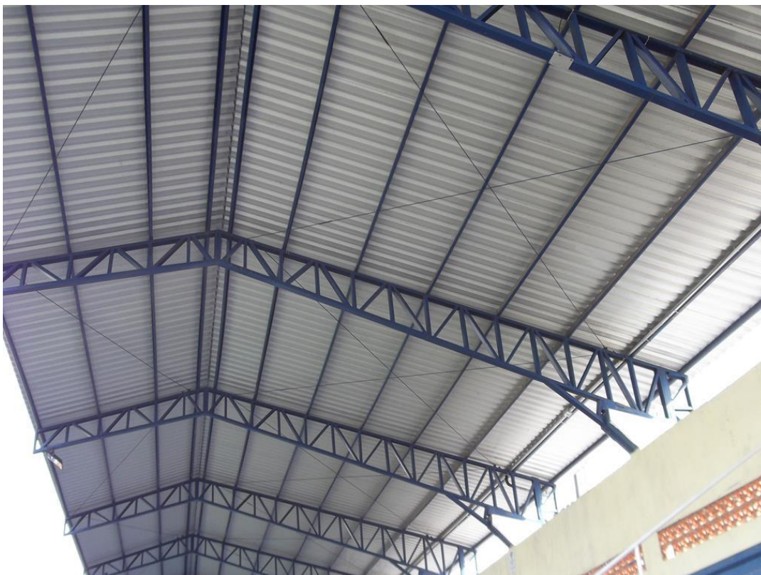
Foto: Sistema de cobertura
