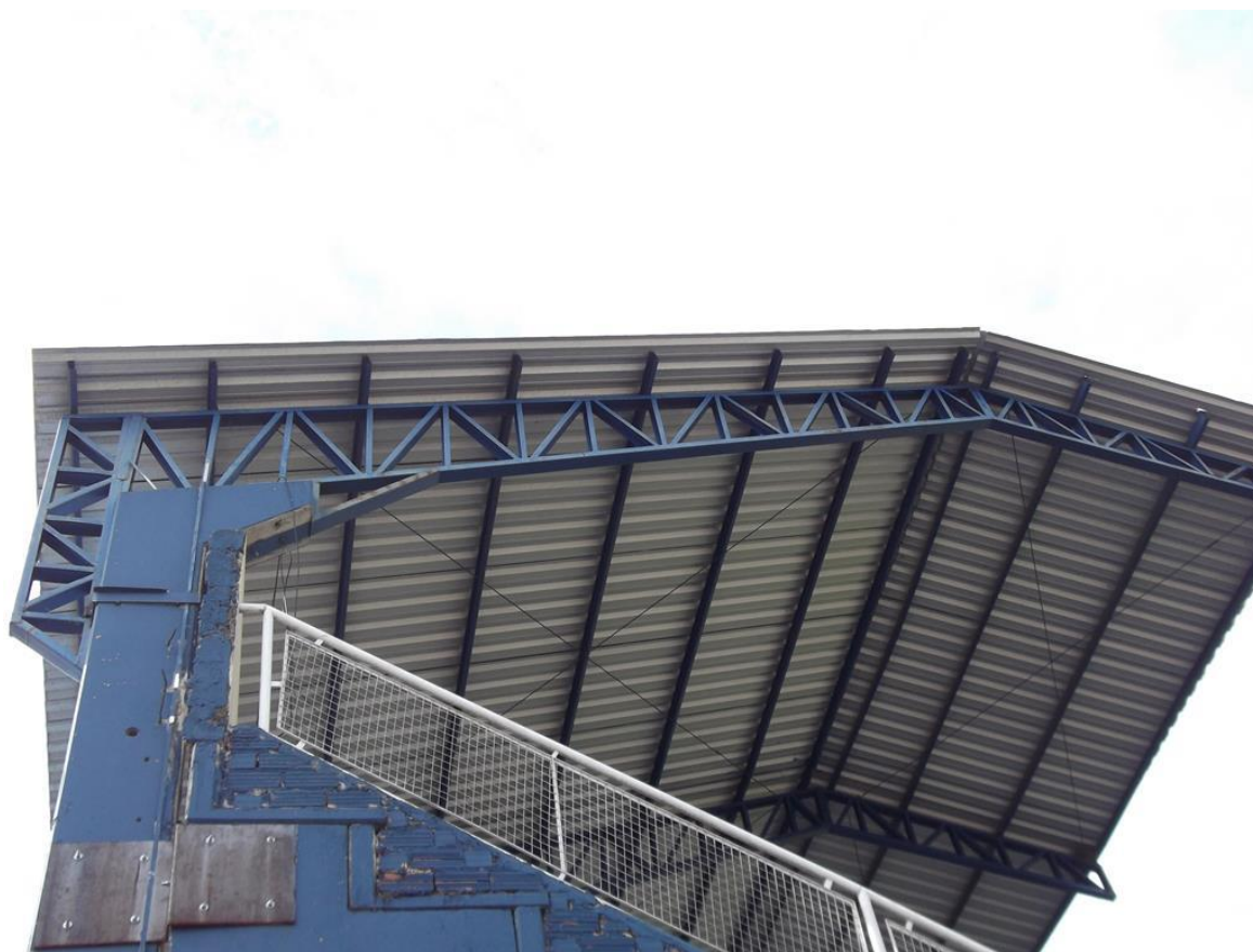
Foto: Sistema de cobertura
