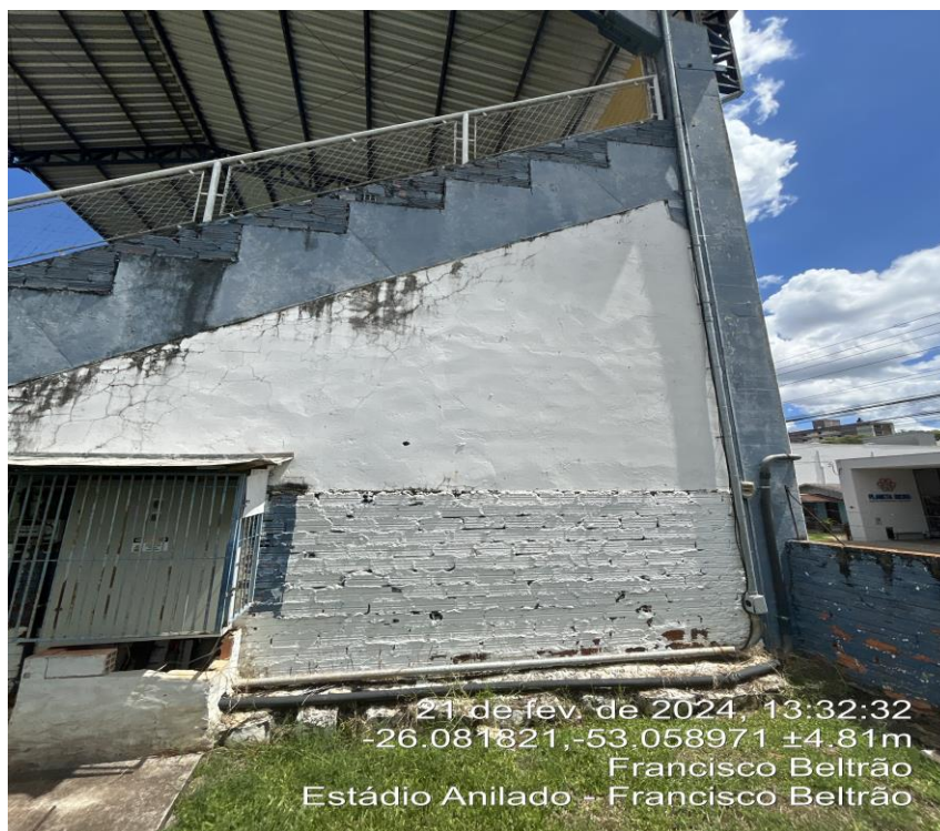
FOTO: Aterramento Lateral esquerda da estrutura metálica
