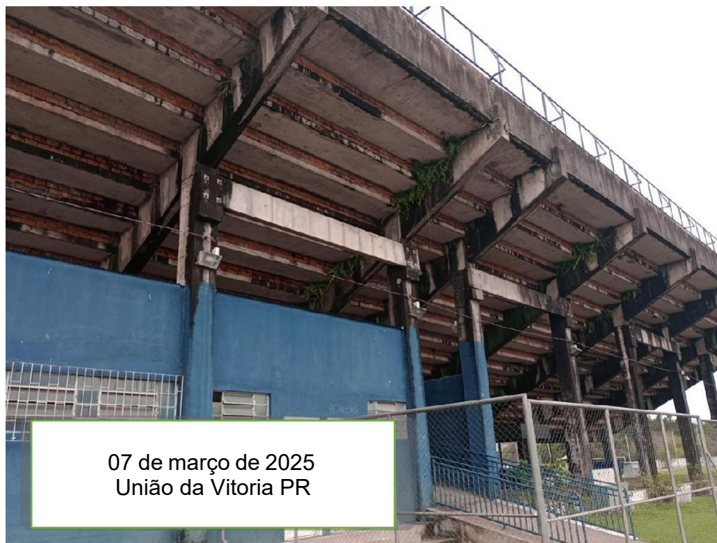
Imagem 42: Infiltração e vegetação intrusiva em lajes, vigas e pilares no Setor C
