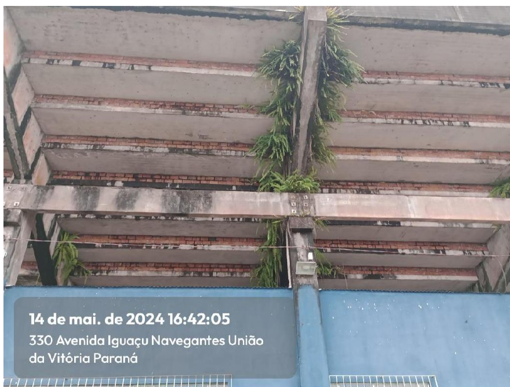
Imagem 40: Infiltração e vegetação intrusiva em lajes e vigas no Setor C
