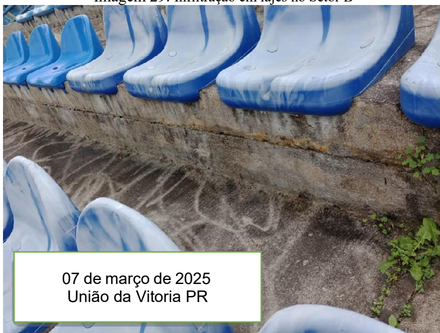
Imagem 30: Trinca entre lajes e a alvenaria no Setor B
