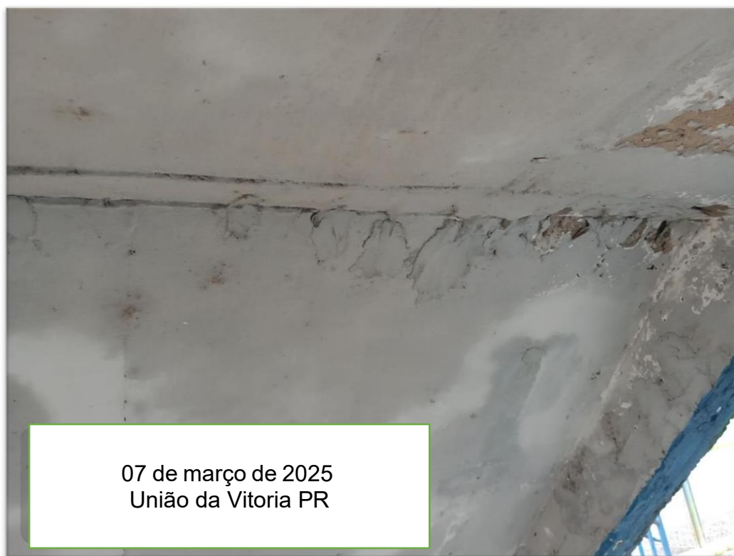
Imagem 10: Infiltração em laje no Setor A
