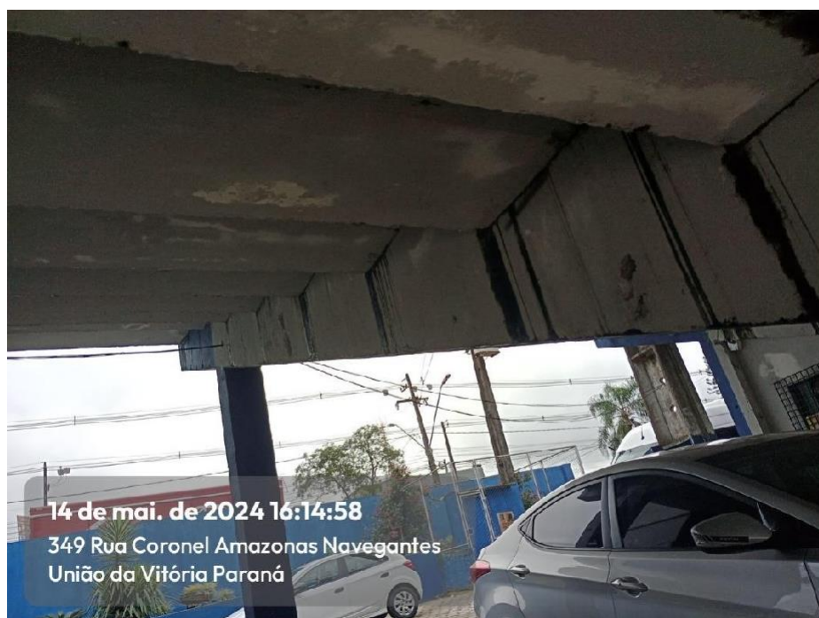
Imagem 07: Infiltração e vegetação intrusiva em viga e lajes no Setor A
