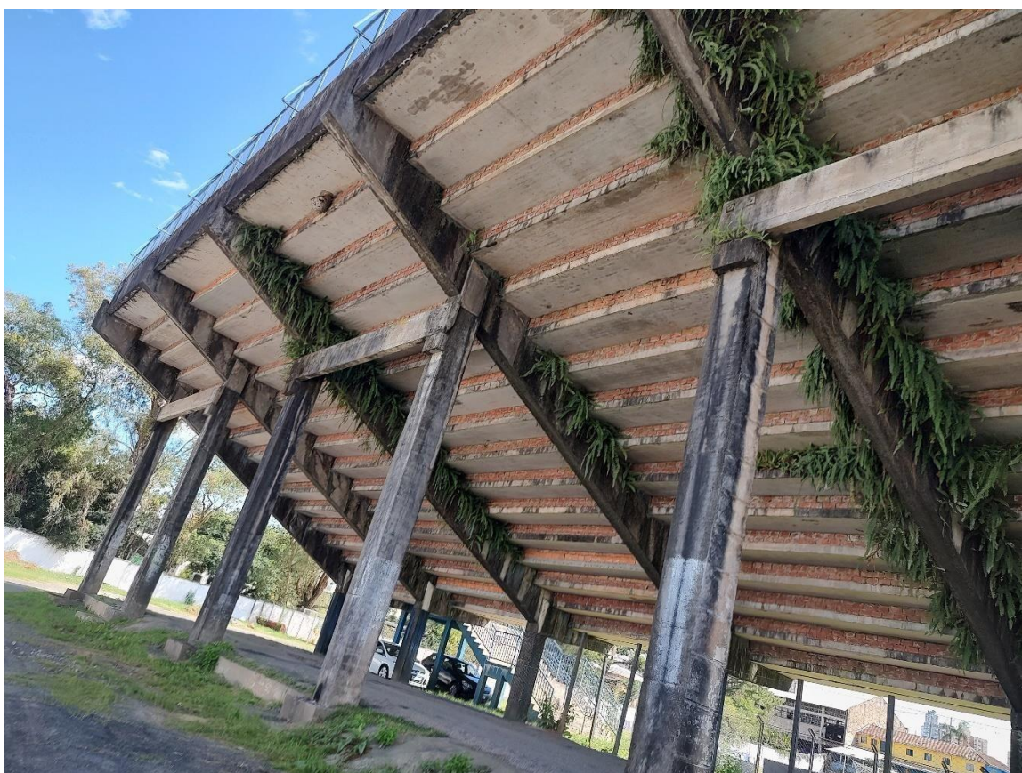
Imagem 40: Infiltração e vegetação intrusiva em lajes e vigas no Setor C
