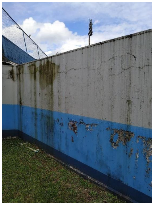
Imagem 89: Infiltração e fissuras na alvenaria no Setor C
