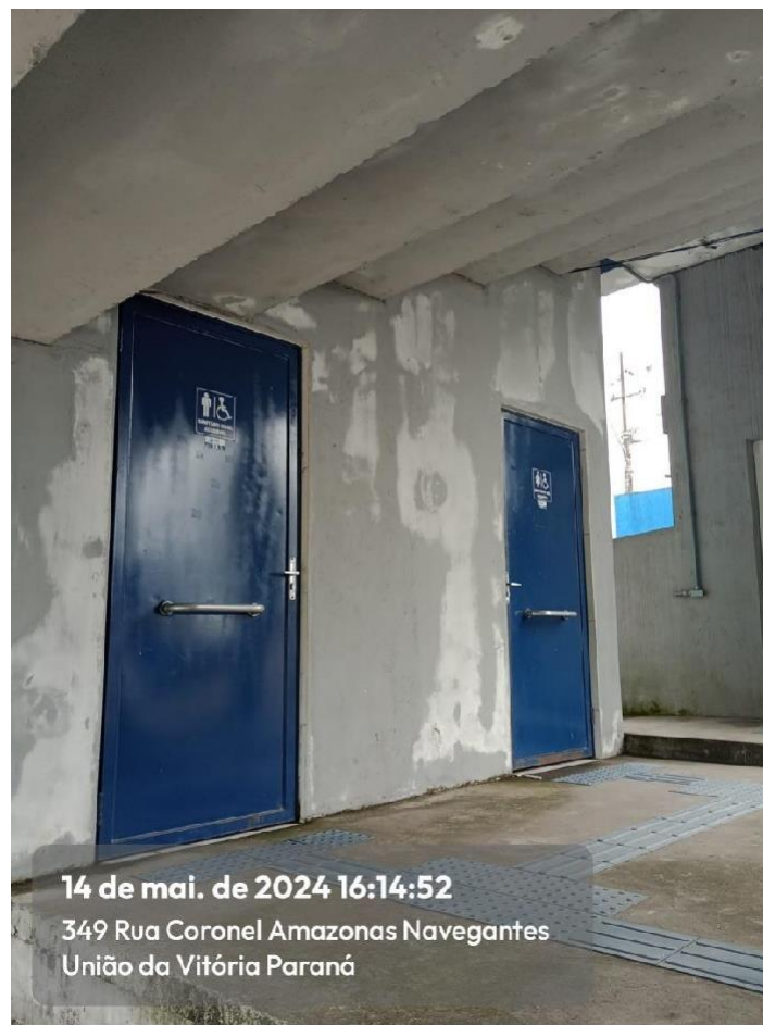
Imagem 06: Infiltração na alvenaria no Setor A
