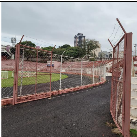
05 – Portão de acesso à torcida visitante.
