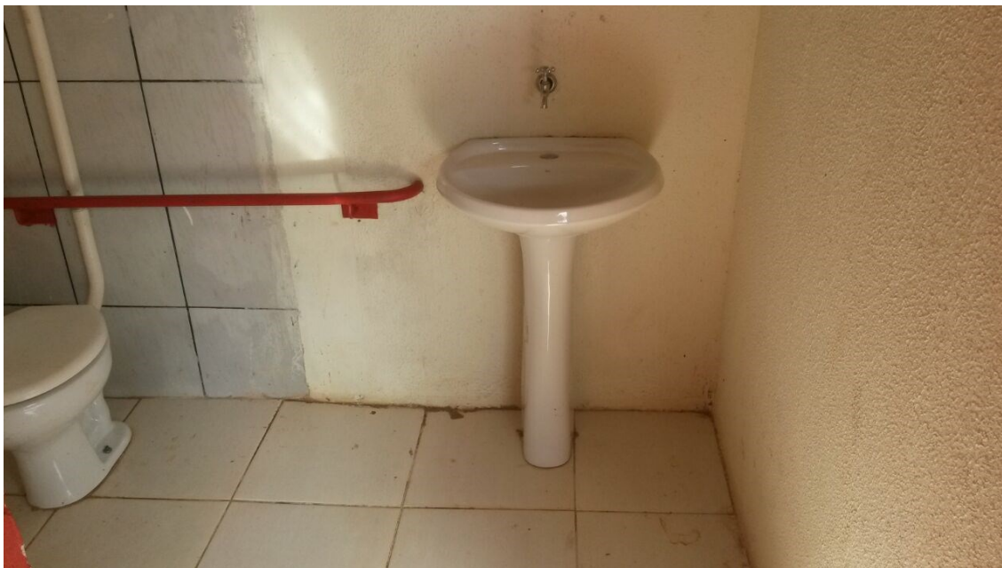
Foto do acesso do banheiro PNE.
